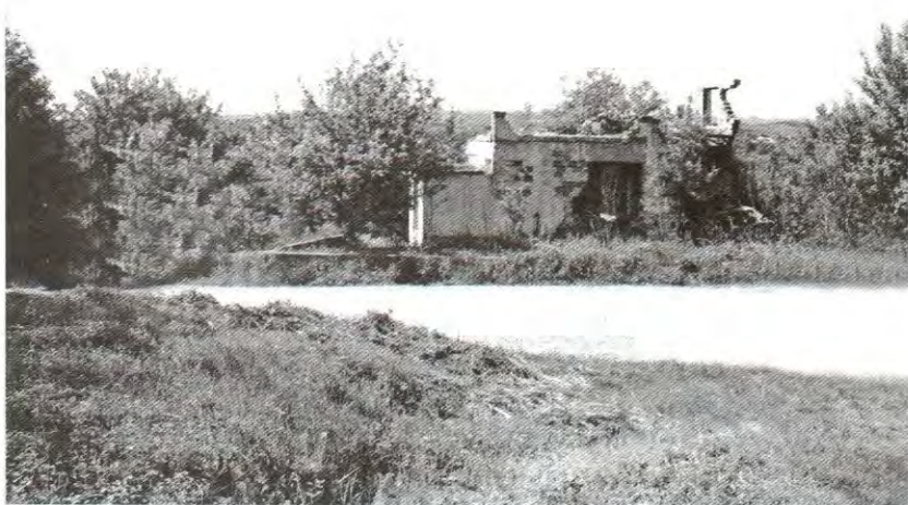
Porušena kuća u Rizvanovićima
