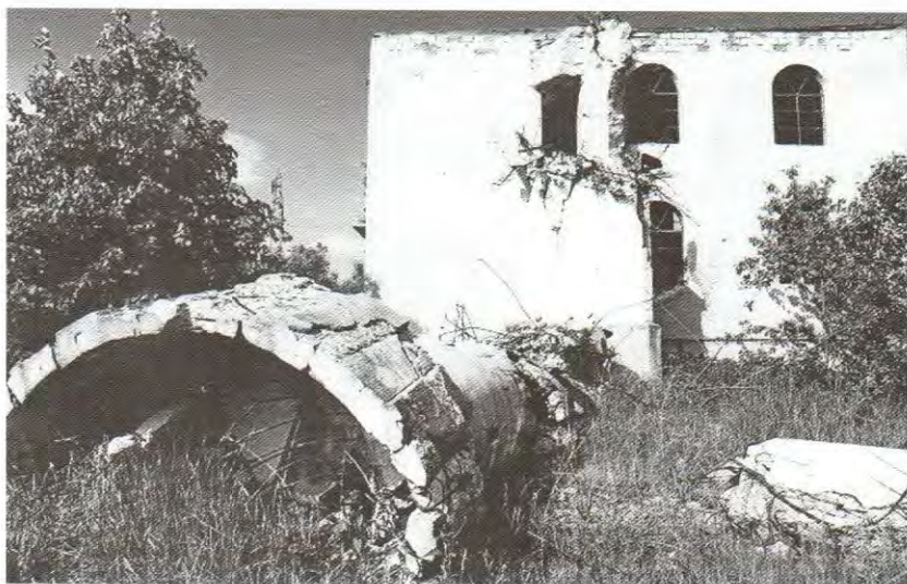
Porušena i oštećena džamija u Brđanima
