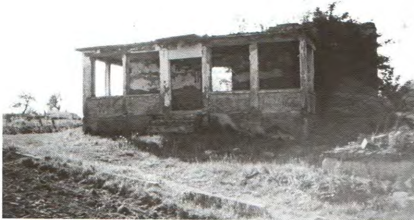
Porušena i oštećena džamija u Čarakovu
