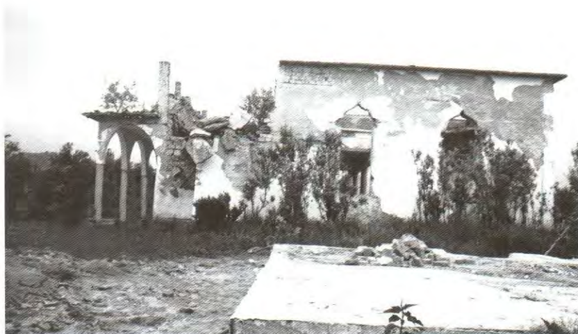
Porušena i oštećena džamija u Čejrecima
